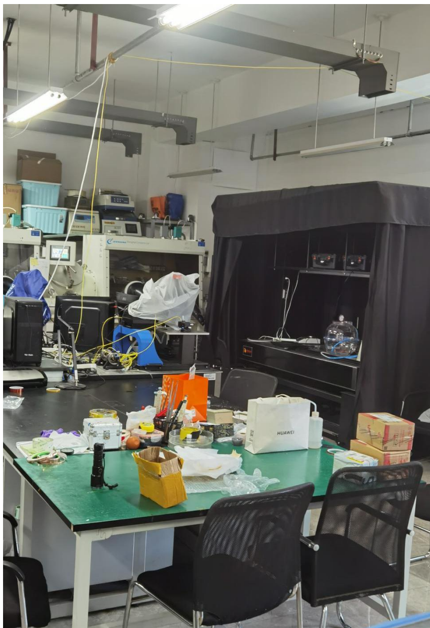
十三、理工楼 1302：配电柜门被堵死
